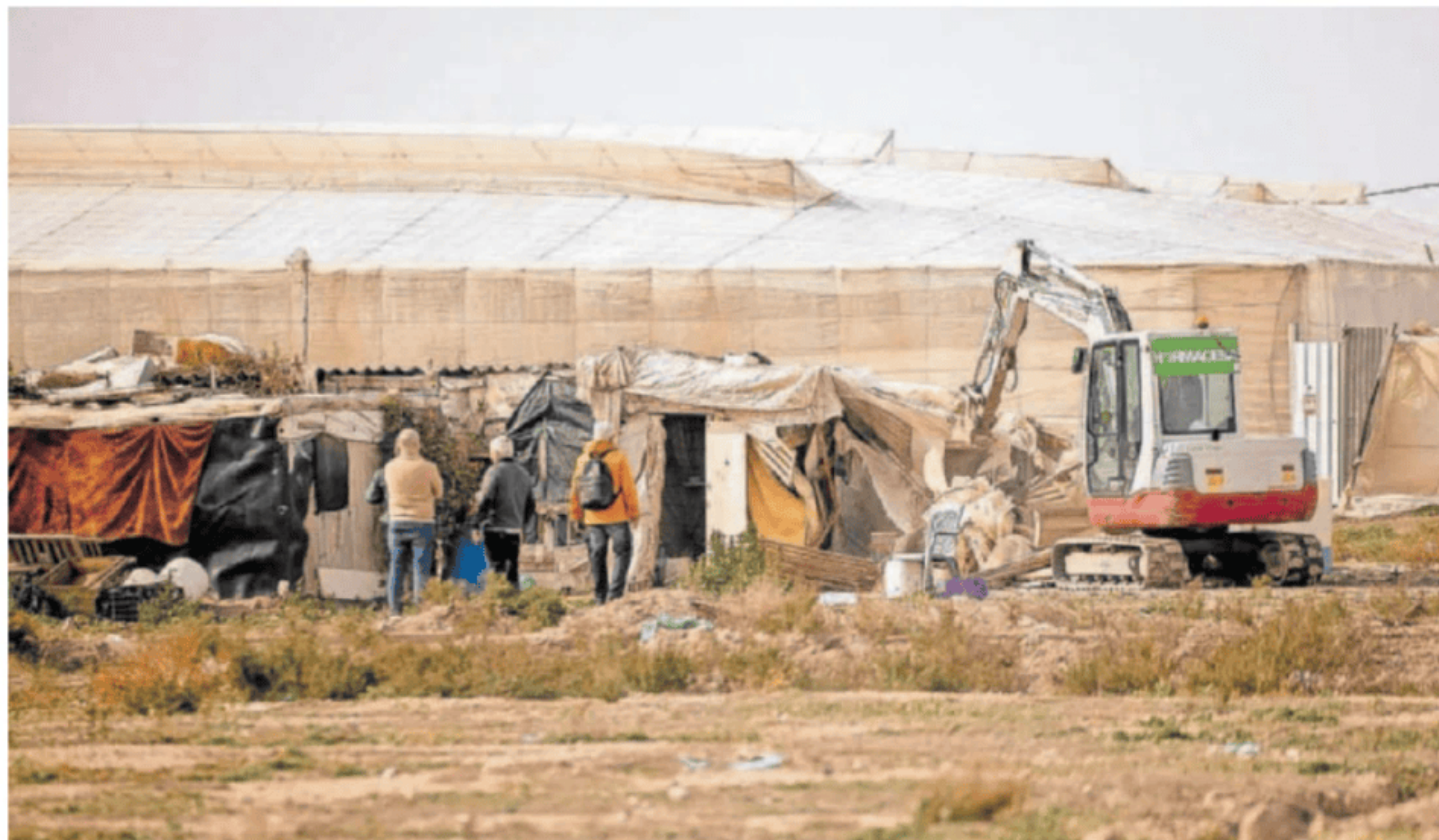
Una excavadora iniciaba, ayer, el derribo de las chabolas del cortijo El Uno, en Níjar. CHEMA ARTERO
