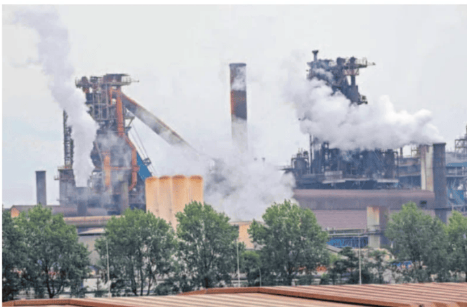
Planta de Arcelor en Gante. JONATHAN RAA (GETTY)
